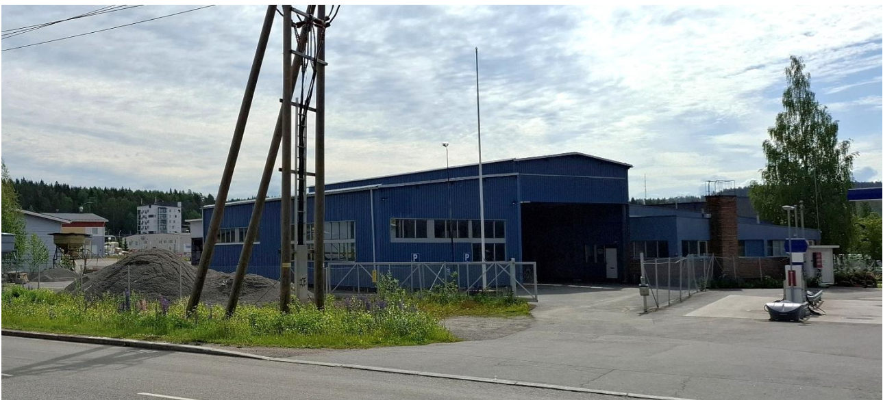
Miilukatu 3 sijaitsee väritykseltään sininen varastorakennus, johon liittyy suuri läpiajettava katosrakennelma.
